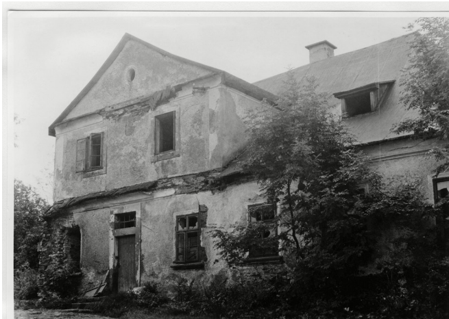
Kolem roku 1960 již nebyla fara, sloužící dočasně i jako sklad JZD, v dobré kondici.
